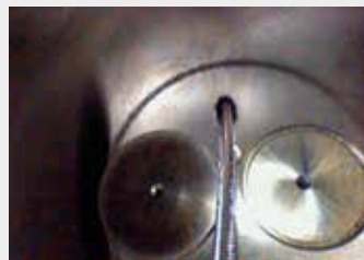
BLICK AUF DIE VENTILE
